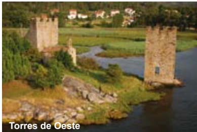
Torres de Oeste
